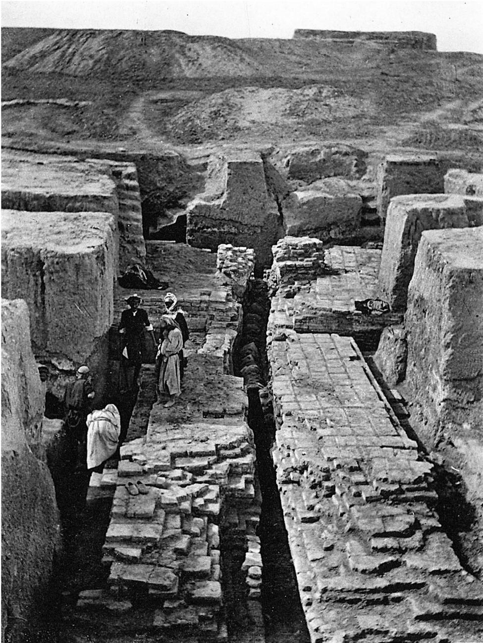
Abbildung 3: Grabungsfoto der Pforte mit Straßenunterbau und Entwässerungskanal im Ostschenkel der inneren Stadtmauer mit Blick nach Westen
