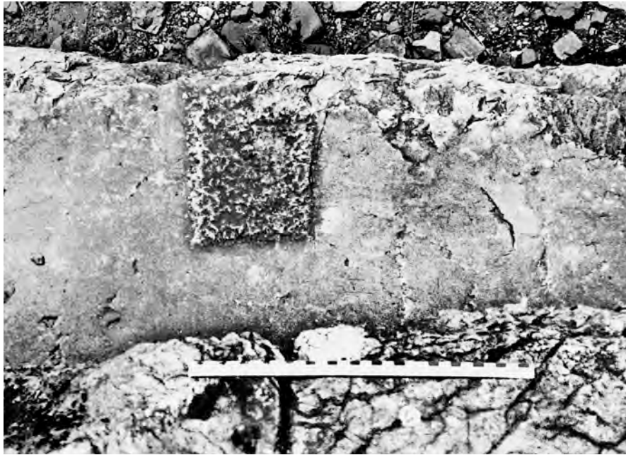
Fig. 15 : Surface libre, en avant du lit d'attente de la première assise de la krêpis : le carré rugueux réservé dans cette partie constitue un témoin de contrôle de l'exécution de la troisième étape du ravalement.
