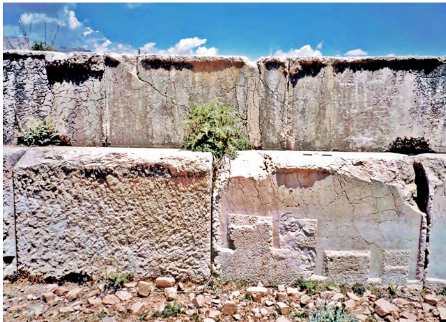
Fig. 12 : Divers stades d'inachèvement du ravalement de la première assise de la krêpis du monument : à gauche le parement est encore brut de carrière; à droite, le ravalement est partiellement terminé.
