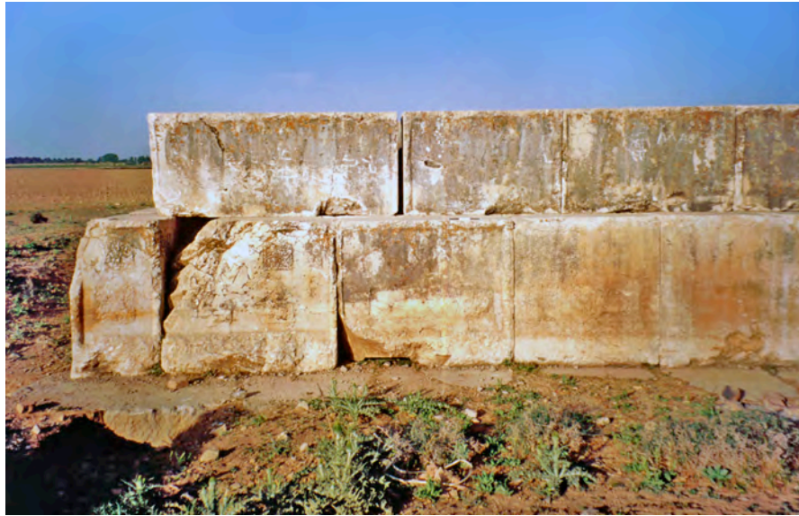
Fig. 13 : Dans l'angle sud-est de la krêpis, la première assise a été totalement lissée.
