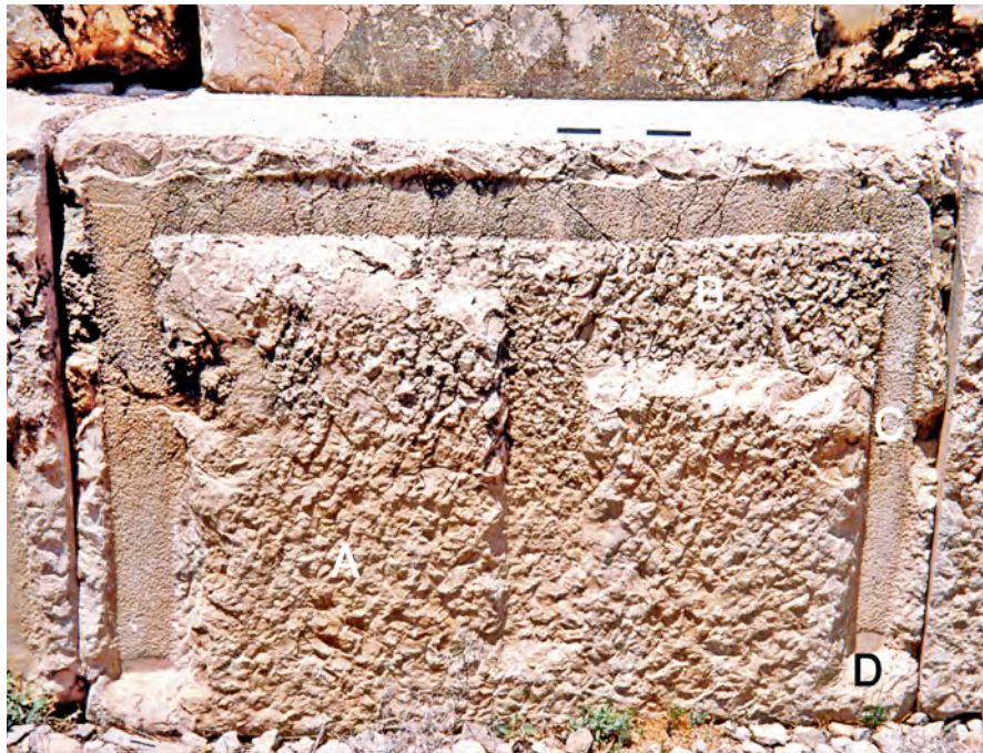
Fig. 16 : Probable parement de référence pour l'exécution des divers stades du ravalement de la krêpis : A) premier stade correspondant à l'équarrissement du bloc en carrière ; B) deuxième stade correspondant au dégagement d'un maximum d'épaisseur de la pierre superflue ; C) suppression des derniers millimètres de pierre en trop ; D) repère de la surface lissée finale
