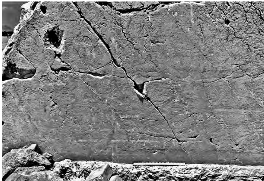
Fig. 17 : Parement égrisé à l'abrasif et préparé pour le creusement d'une petite mortaise en vue de l'insertion d'un bouchon de pierre.
