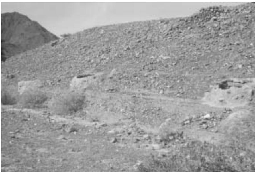
fig. 7 : ligne de regards sur une galerie de sous-écoulement près de Bithnah dans la montagne d'Oman.
