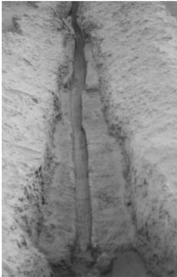
fig. 13 : conduit aérien terminal de la *qanāt* «MQ11». Vue vers le sud du chenal équipé d'éléments en céramique au profil en «U». Cf. <http://www.thotm-editions.com/qanats/wuttmann/figure13.htm>.
